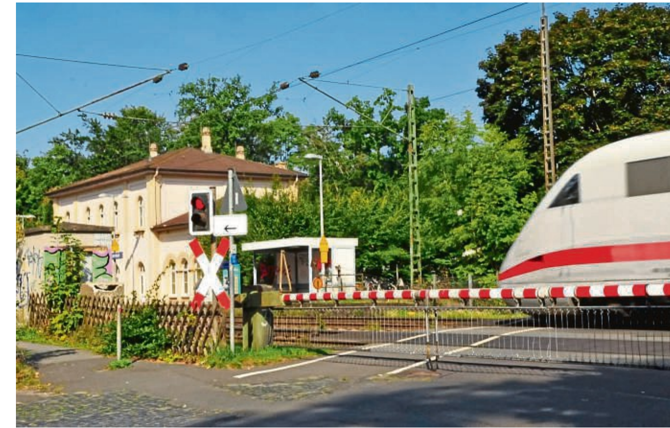
Die Erweiterung der Bahnstrecke Hanau-Frankfurt für die Nordmainische S-Bahn wird der Bahnhof Wilhelmsbad nicht überleben. Der Plan sieht vor, das Gebäude abzureißen und neu zu errichten. FOTO: KARIN KLEMT
